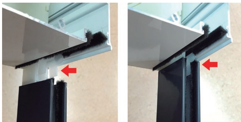
Figura 60. Unión ventana cajón
